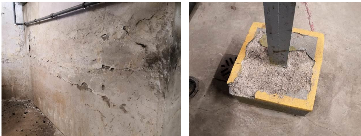
Obrázek 3: Degradace povrchové vrstvy betonu v místě zvýšené vlhkosti stávající ČOV
